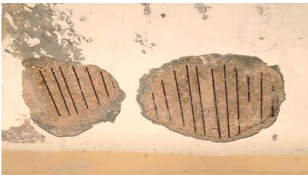
Figura 1. Desprendimiento del recubrimiento en una losa de hormigón armado
