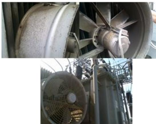
**Fig. 2. Deposición del polvo de las canteras en los ventiladores de la subestación**
