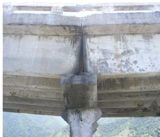
Fig. 4. Fallos por socavación de pilas centrales. Afectaciones en el tablero isostático.
