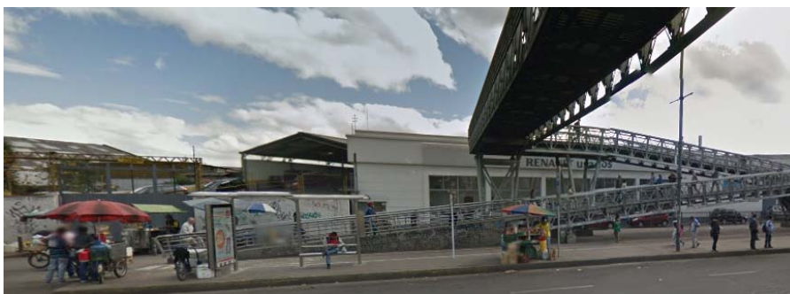
Fig. 4. Imagen Puente Peatonal Estación Carrera 53 A - Acceso norte
