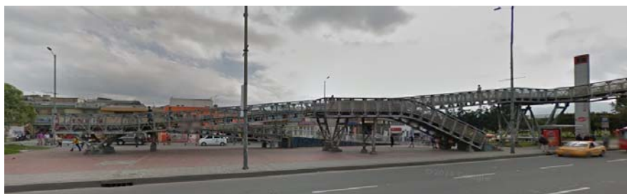
Fig. 8. Imagen Puente Peatonal Estación Marsella - Acceso norte
