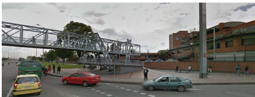
Fig. 6. Imagen Puente Peatonal Estación Pradera - Acceso norte
