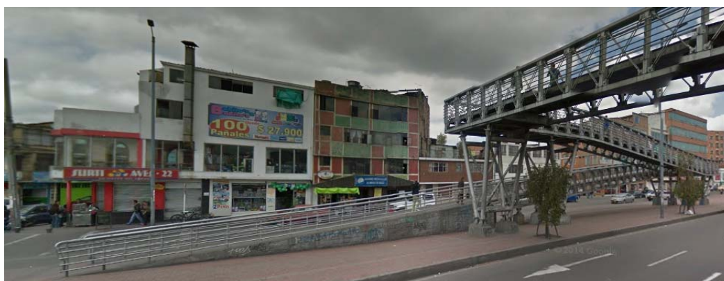
Fig. 5. Imagen Puente Peatonal Estación Carrera 60 - Acceso norte
